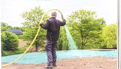
Hydroseeding wordt met een brandweerspuit aangebracht
